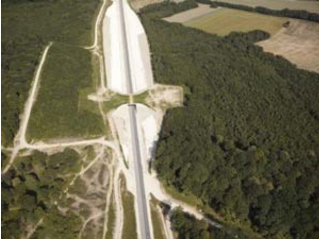
Passage Grande Faune supérieur LGV Rhin-Rhône branche Est
