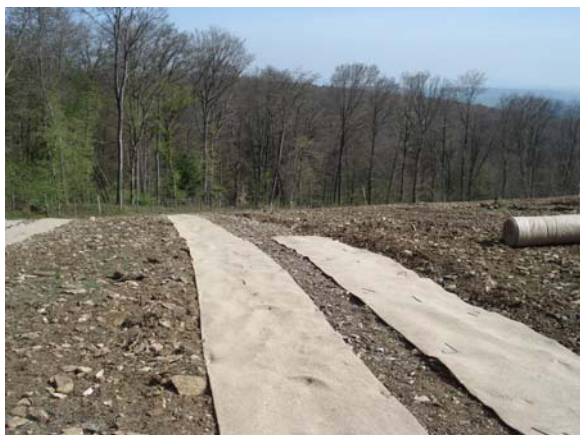
Fig 2 : Mise en place du feutre biodégradable avant plantation (mars 2010)
